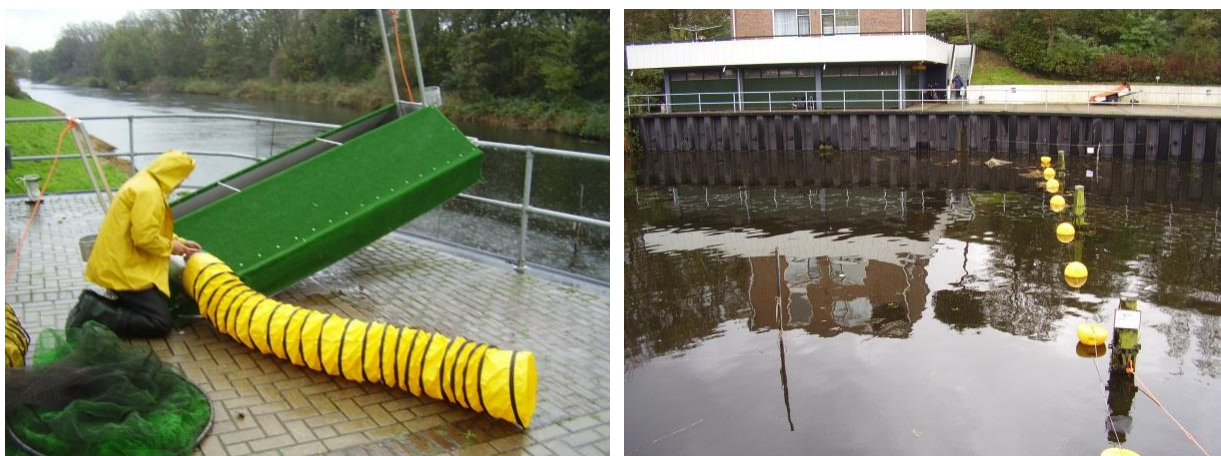
Figuur 3.3. Plaatsing goot bij gemaal Schoute
