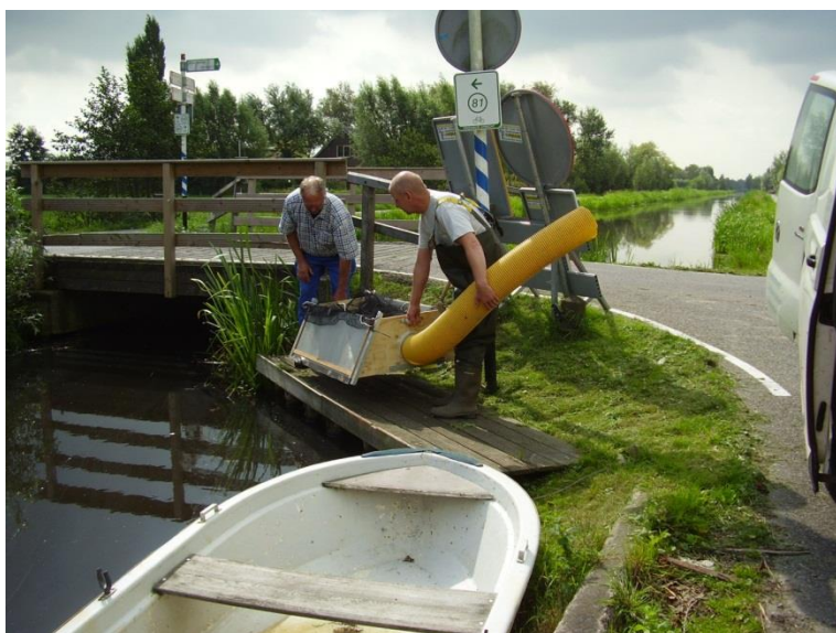
Figuur 3.4. Plaatsen goot in de Kamerikse wetering
